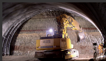
Tunel Jagdberg ■ vedení stavby, stavební dozor, zaměření stavby
