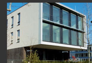
Kancelářská budova Mnichov ■ statická zkouška a zkouška stavebních konstrukcí
