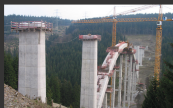
Most Oelztal ■ statická zkouška a zkouška stavební konstrukce
