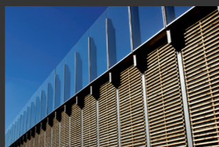
A 113, Berlín ochranné protihlukové zařízení Johannisthaler Chaussee ■ projektový plán, návrh inženýrských staveb, nosných konstrukcí, posouzení návrhu
