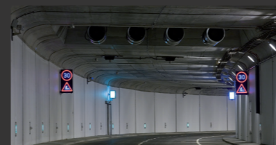
Kombinované řešení Karlsruhe, Tunel Kriegsstraße ■ Odbornost, plánování objektů, inženýrské stavby, technické vybavení, konstrukční návrh, ventilační a imisní zprávy, celková bezpečnostní koncepce, logistická koncepce, plánování alarmů a obrany
