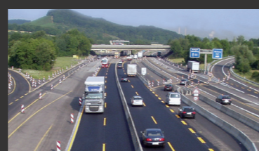
A.6 Dálniční křižovatka Weinsberg ■ stavební dozor
